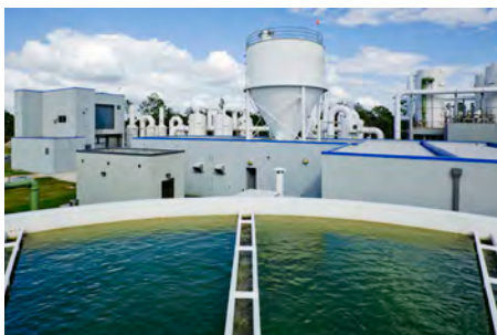
Agua potable y aguas residuales
